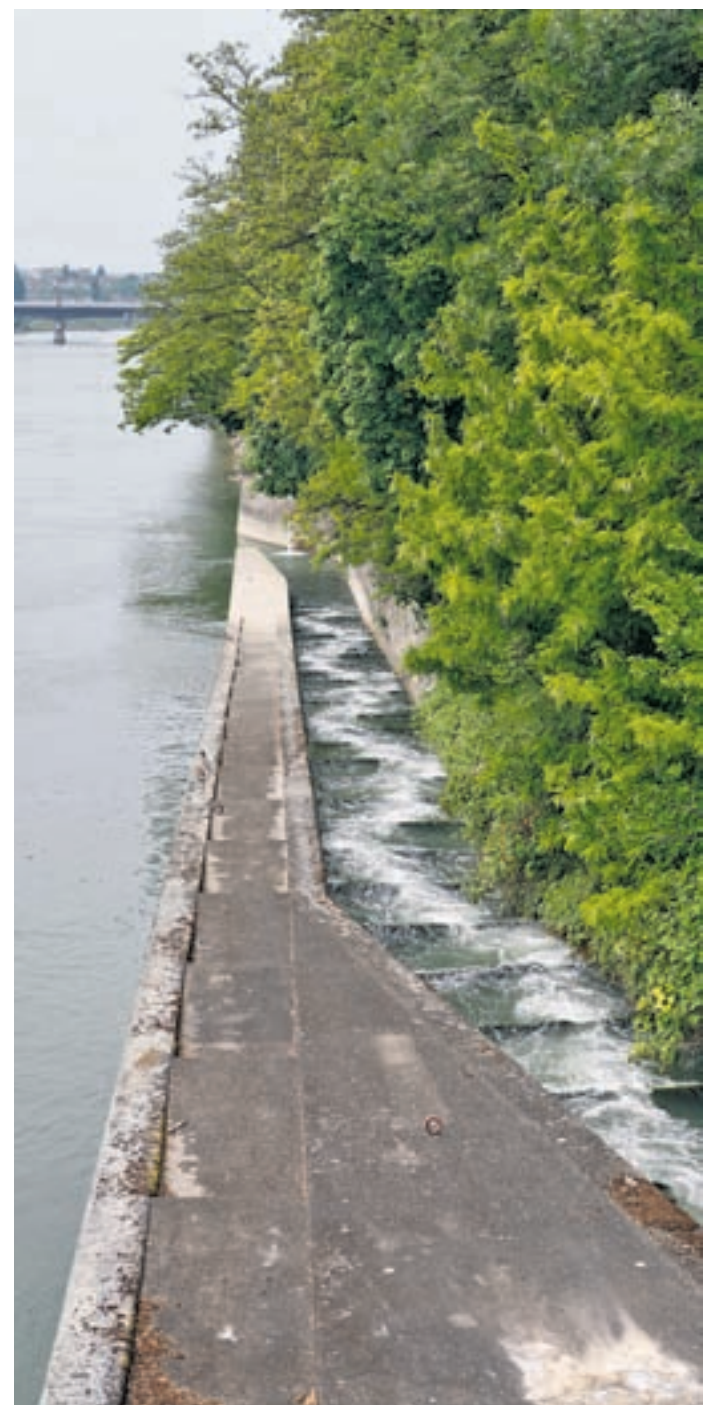
Nicht ideal. Beim Kraftwerk Birsfelden ist das Gewässer am Anfang der Fischtreppe zu ruhig. Foto Misha Christen
