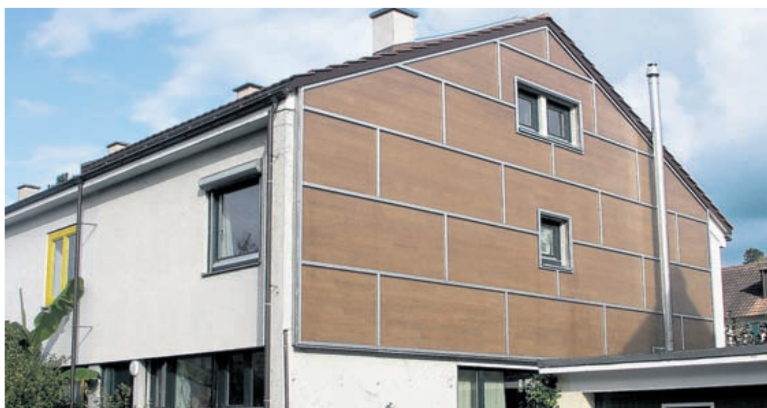
Sanierung in Riehen. Eine «Lucido-Fassade» bringt bei diesem Haus eine effiziente Wärmedämmung. Foto Lucido
